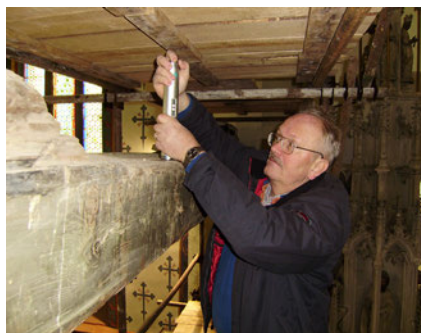
Obr. 5: Kvalita trámu v bazilike sv. Egídia hodnotená prístrojom Pilodyn 6J.
