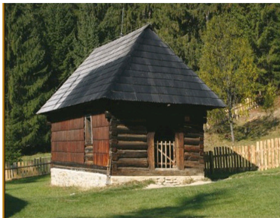
Obr. 3: Zrubové steny lisovne oleja v skanzene Zuberec.
