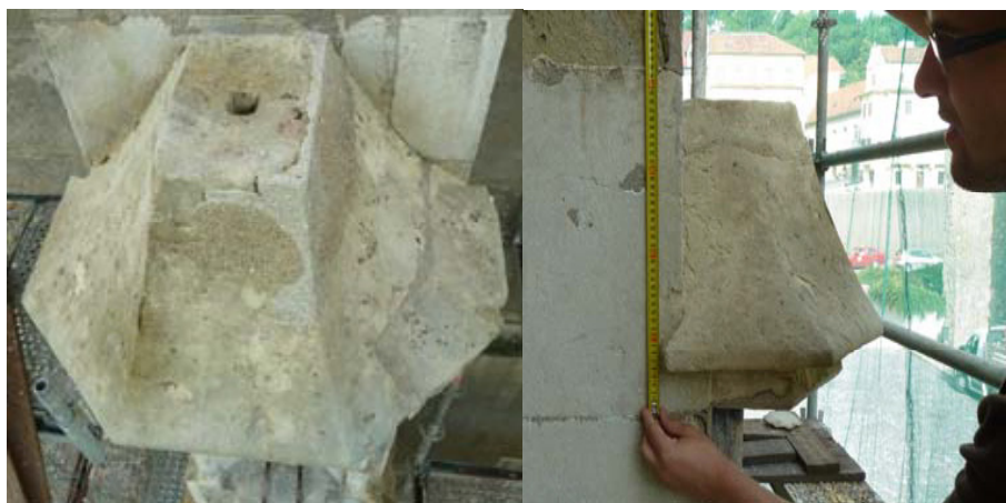
Obr. 2: Zameranie pôvodných pieskovcových hlavíc z 19. storočia in-situ.
