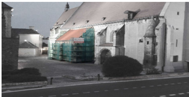
Obr. 1: Kaplnka sv. Anny s lešením v čase rekonštrukčných prác v roku 2012.
