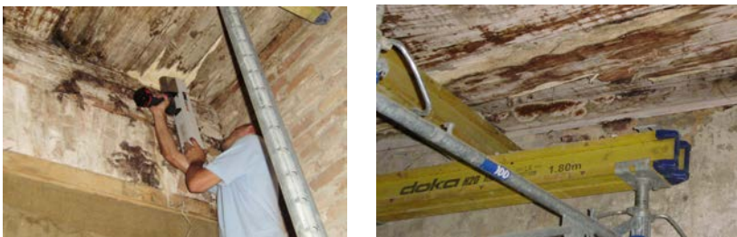
Obr. 3: Ukážky: (a) Strop nad miestnosťou 3.21 – hnilý trám č. 18 s plodnicami huby Antrodia vaillantii a vrt č. 5 Resistographom, viď aj obr. 4a; (b) Strop nad miestnosťou 3.10 – hnilé trámy č. 45-47 s plodnicami huby Serpula lacrymans .
