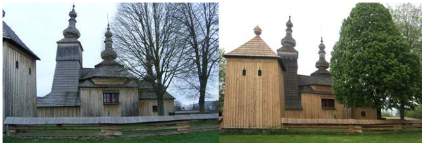
Obr. 3 – 4: Grécko-katolícky kostol sv. Michala Archanjela v Ladomirovej. Vľavo – stav pred očistením, apríl 2014, vpravo – očistené oplatenie a opláštenie kostola a zvonice, máj 2015.
