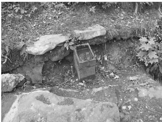
Obr. 6: Zbytek konstrukce kovové patky experimentálního přístřešku na centrálním reliéfu.
