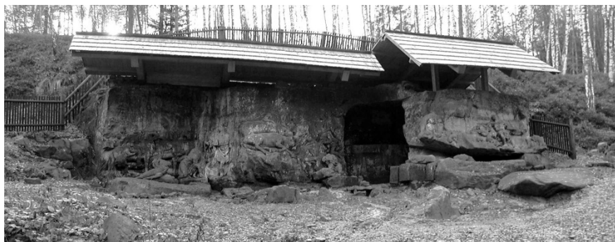
Obr. 5: Dočasný přístřešek nad reliéf v centrální části areálu.
