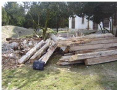
Obr. 1: Kaštieľ v Rusovciach (a) a hnilobou i požerkami poškodené trámy vynesené pred kaštieľ (b).
